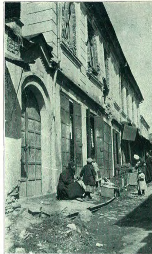
Monastir bombardée : Le petit commerce dans les rues à maisons démolies ou endommagées. Phot. Reiss.
