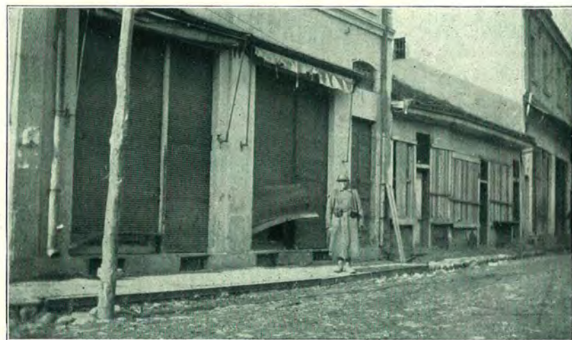
Monastir: Magasins fracturés par les Bulgares avant l'évacuation de la ville.
